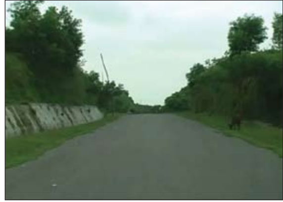
চিত্র-২: ঢাকা ট্রাংক রোড হতে বায়েজিদ বোস্তামী রোড পর্যন্ত সংযোগ সড়ক নির্মাণ (বর্তমান অবস্থা)
