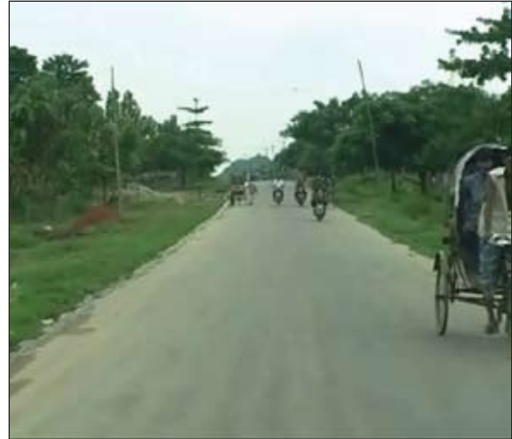
চিত্র-৩: ঢাকা ট্রাংক রোড হতে বায়েজিদ বোস্তামী রোড পর্যন্ত সংযোগ সড়ক নির্মাণ (বর্তমান অবস্থা)
