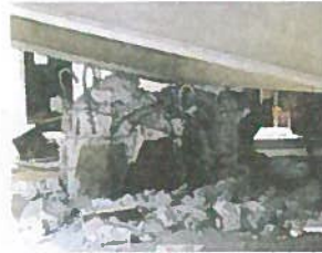
柱中央に於けるRC柱の剪断破壊 (Failure at mid height column)
